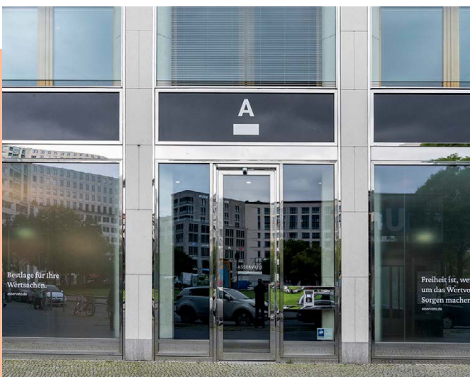
Zentral. Diese Schließfachanlage von Asservato befindet sich im Zentrum von Berlin. Sie ist auch mit öffentlichen Verkehrsmitteln erreichbar.
