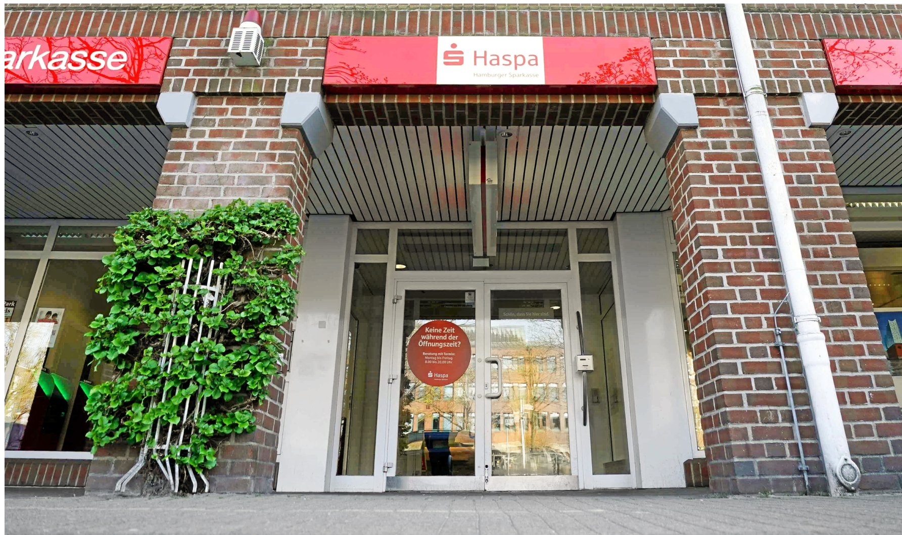
Die unbekannt Täter drangen im August 2021 in Norderstedt mit einem Kernbohrer aus einer Wohnung über der Filiale in den Tresorraum ein.
